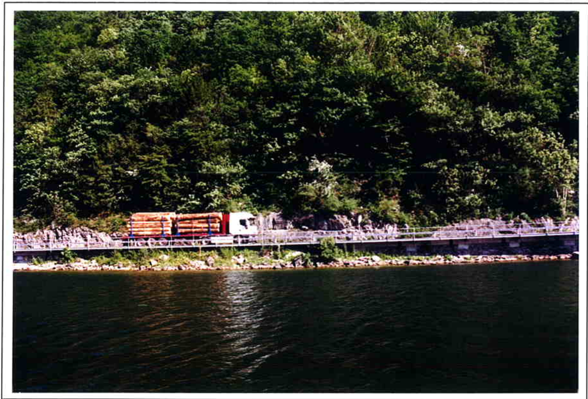
Foto 00/29-7: „Kantonsstrasse Lopper Süd Stansstad“
