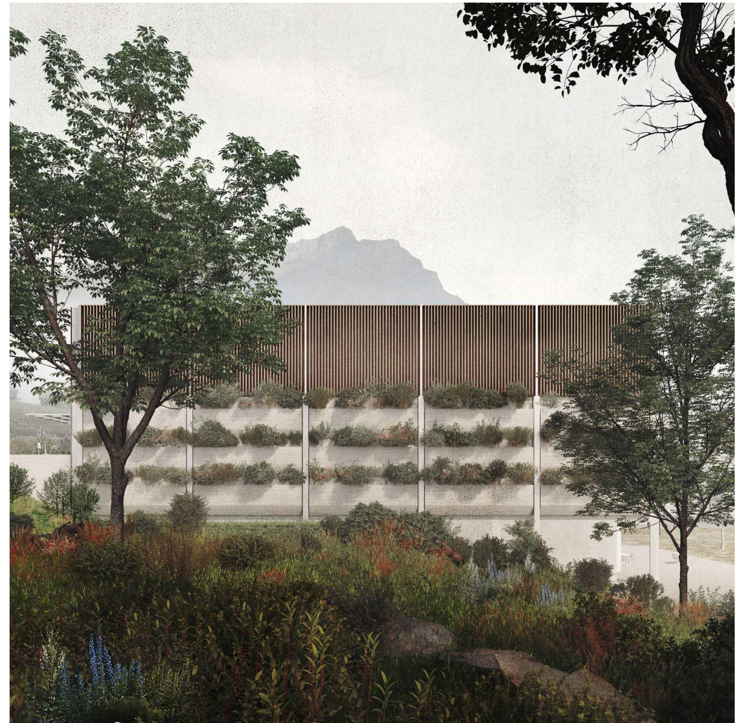
Die bestehenden Fassadenelemente aus Beton werden demontiert und als Pflanztröge an der Ostfassade wiederverwendet.
