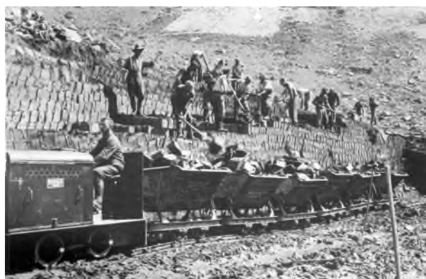
Bau des Staudamms auf der Bannalp, Staatsarchiv Nidwalden
