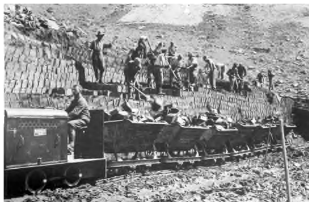
Bau des Staudamms auf der Bannalp, Staatsarchiv Nidwalden
