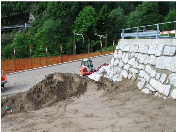
Moderne, mit Maschinen errichtete Zyklopenmauern
