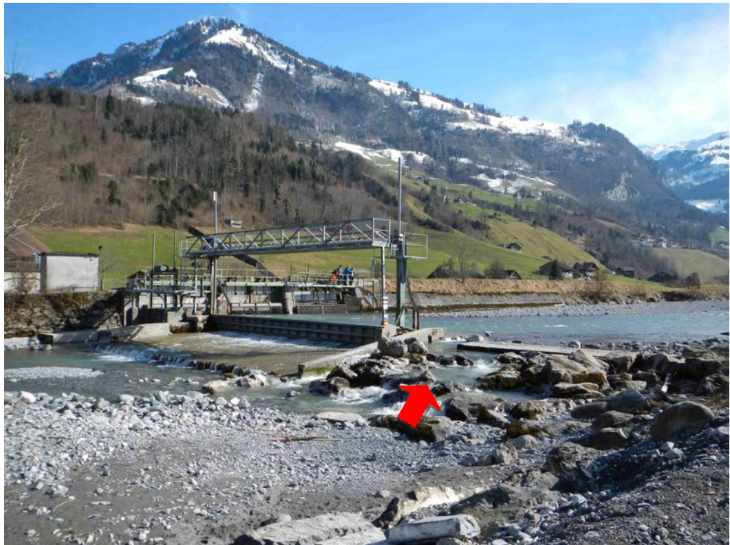
Abb. 4: Hostettenwehr mit Fischaufstieg
