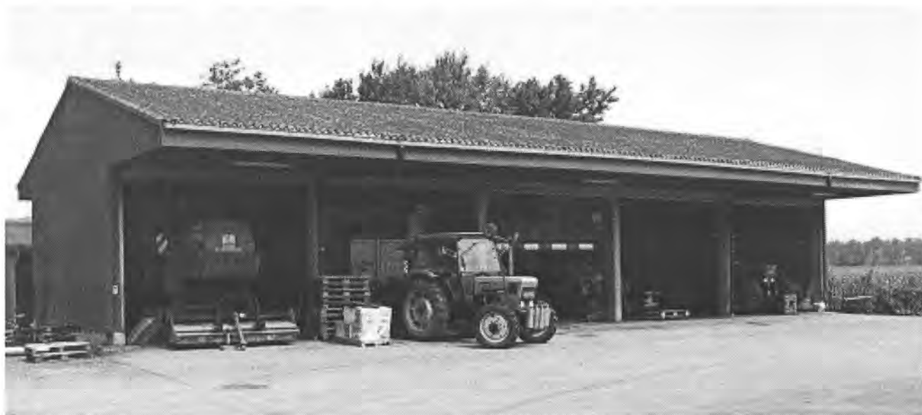
Abb. 1: Einseitig offene Remise mit grossem Vordach. Eine praktische und kostengünstige Lösung.
