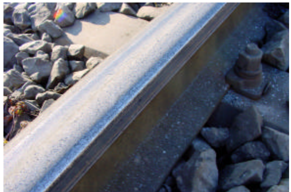
Abb. 8.3 Industriegleis mit schwachen Riffelbildungen Die SBB ersetzen daher bei mehreren Wagentypen (EW I und II) die Graugussklotzbremsen durch sogenannte Sintermetallklotzbremsen (saniertes Wagenmaterial mit türkisblauem Streifen gekennzeichnet).
