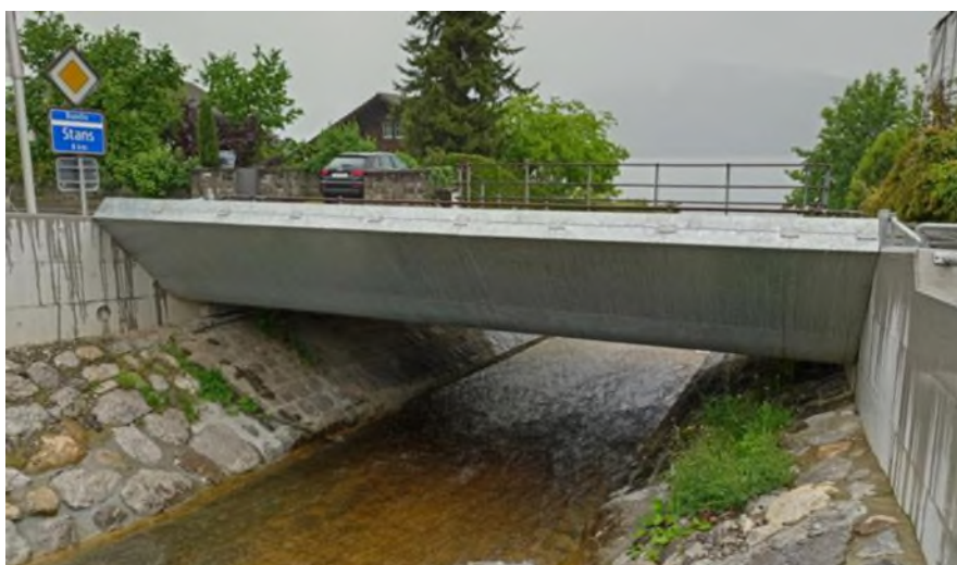
Abbildung 29 Foto Träschlibach Brücke
