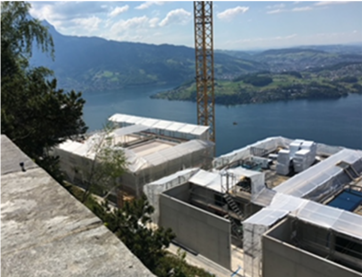
Abbildung 22 Baustelle auf dem Bürgerstock noch ohne die passende Fassadenverkleidung, Ennetbürgen
