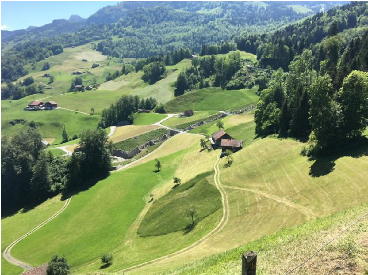
Abbildung 7 Hanggebiet oberhalb von Beckenried mit Hochwasserschutzbauten Träschlibach, Beckenried
