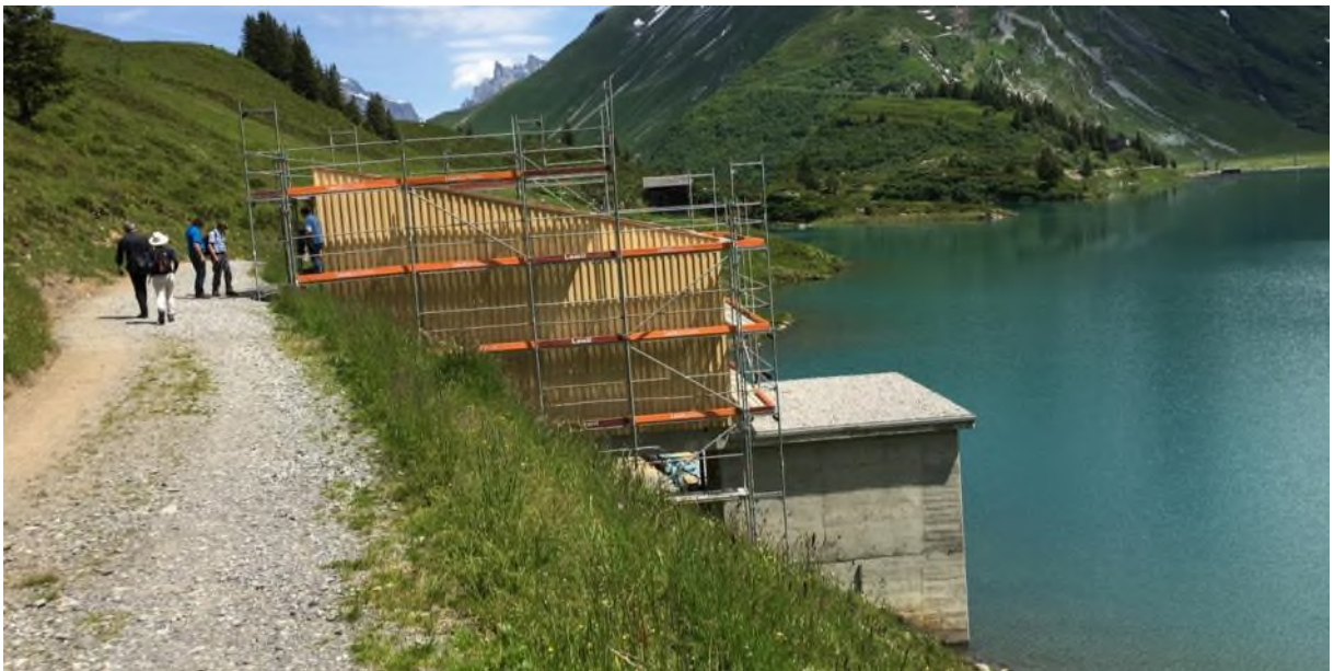
Abbildung 14 Anlage für Wasserentnahme aus dem Trübsee, Wolfenschiessen
