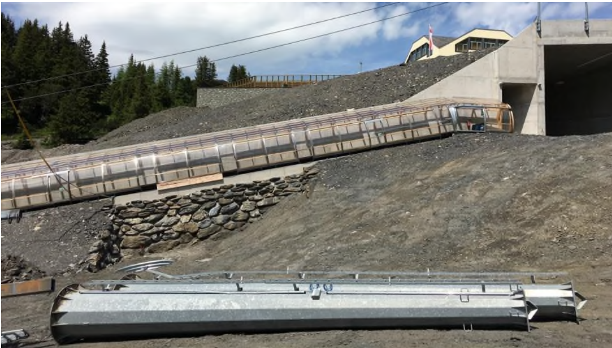
Abbildung 13 Bauzustand Zwischenstation Trübsee der Gondelbahn Engelberg-Stand mit Förderband für Skifahrer, Wolfenschiessen
