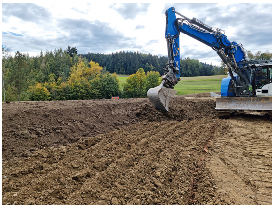
Schichtweiser Bodenauftrag in Streifen (Foto: Dominik Müller)
