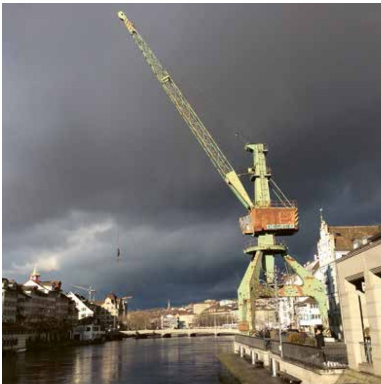
zürich transit maritim (Hafenkran), 2014, Jan Morgenthaler, Barbara Roth, Martin Senn, Fariba Sepehrnia. Limmatquai, Zürich
