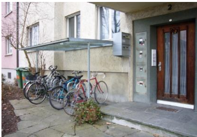
Nahe am Eingang, überdacht und Velorahmen anschliessbar. Diese Anlage ist für Kurz- und Langzeitparkierung geeignet.
