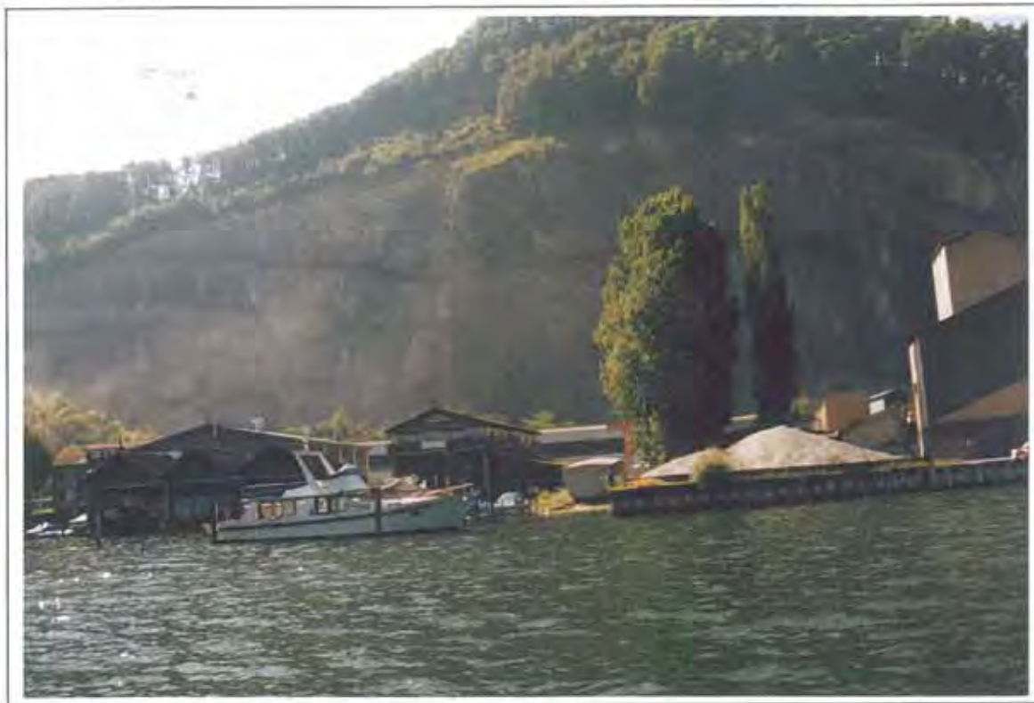
Foto 00/29-23A: „Steinbruch Rotzloch, Stansstad“
