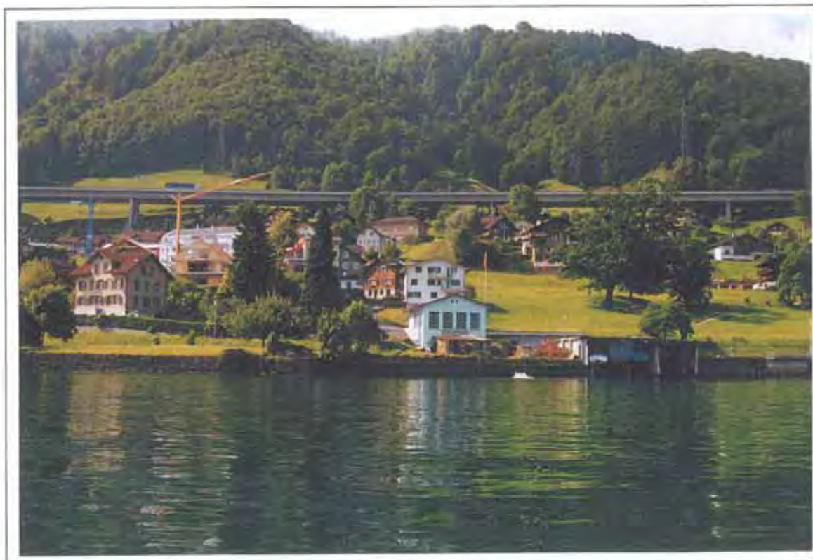
Foto 00/26-14: „Siedlungsgebiet Beckenried mit Ufermauer“
