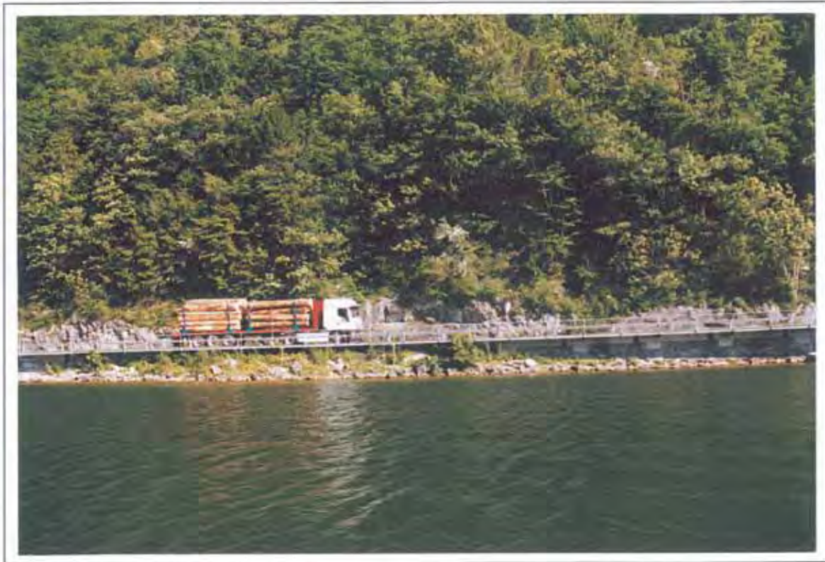
Foto 00/29-7: „Kantonsstrasse Lopper Süd Stansstad“
